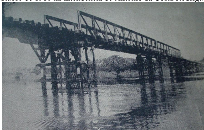
Fig. 15: Ponte metálica do Sapucaia sobre o rio Caeté em Bragança, inaugurada em 02 de outubro de 1910 na intendência de Antônio da Costa Rodrigues.
