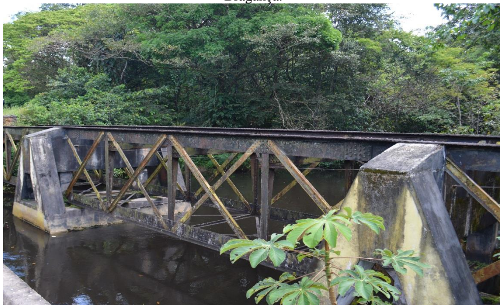
Fig. 2: Ponte metálica sobre o Rio Jambu-Açú localizada às margens da PA 320, na divisão das cidades de São Francisco do Pará e Igarapé-Açú, estrutura remanescente da extinta Estrada de Ferro de Bragança.
