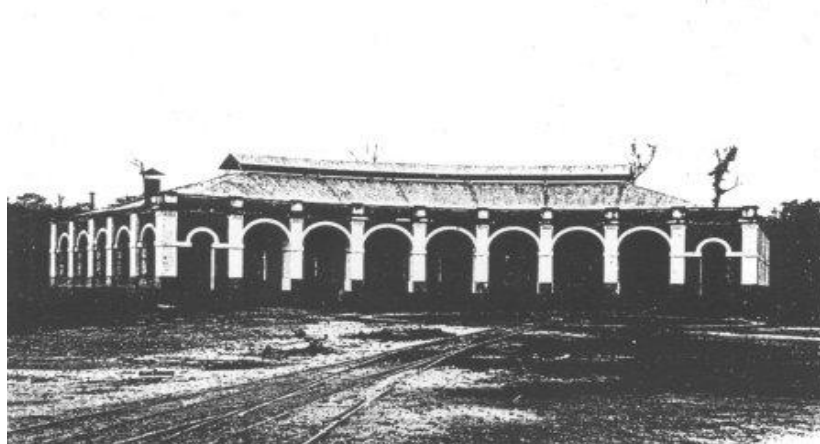
Fig. 8: Prédio da rotunda para locomotivas em Marituba. Autor e ano desconhecidos.
