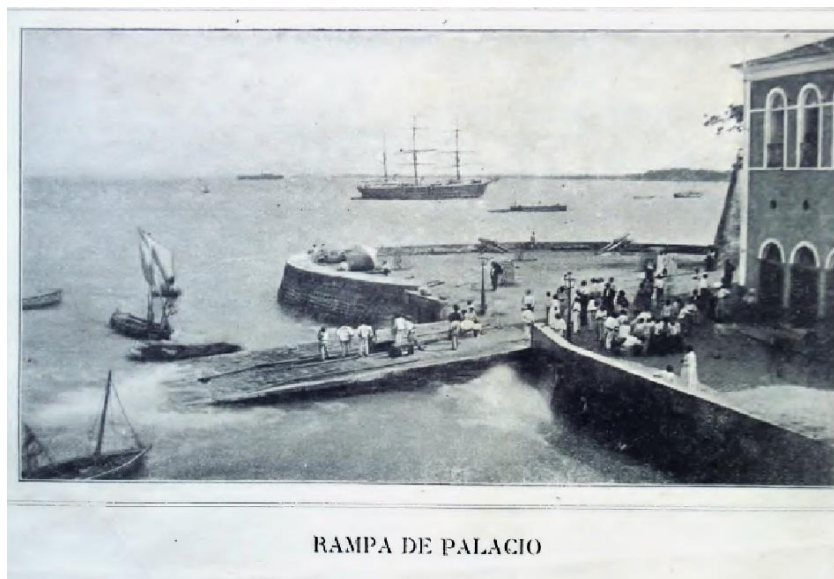
Figura 1 — Rampa do Palácio
